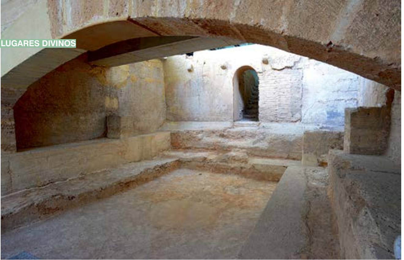
Arco rebajado que sustenta el espacio central de la bodega, con la escalería (al fondo) por la que se accedía a la misma.
